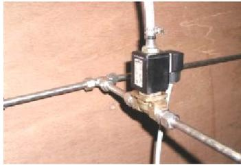
Das Hochdruckventil für Mehrabteilställe wird mit den Endverschraubungen mit dem Rohrsystem verbunden (P=Eingang, A=Ausgang). Wenn das Ventil schließt, wird die angeschlossene Sprühlinie entlastet. Das Wasser muß über einen Schlauch abgeleitet werden.
