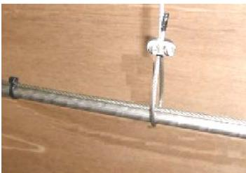
Düsenlinien können mit einem Spanndraht abgehängt werden. Den Spanndraht alle 3m nach oben abhängen. Die Düsenlinien mit Rohschellen oder mit Kabelbindern am Spanndraht befestigen:
